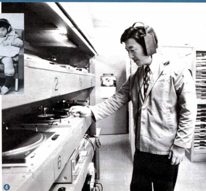
写真③: 東京・水道端図書館 / 椅子の間に設置されたスイッチボックス・アダプターのスイッチを聴取者が切り換え、好みのプログラムを選択して楽しんでいる。 写真④: 早稲田大学・図書館 / コントロール・ルームの送り出しシステム。多数のプレーヤー、テープデッキ、チューナなどの送り出し機器をコントロールし、聴取者へ複数のソースを送り出す。写真はイヤースピーカーでモニターしながらレコードをソースとして送り出しているところ。
